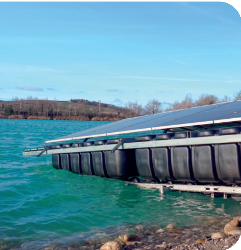
ZU WASSER Nachdem die PV-Anlage auf dem Land montiert wurde, gingen die einzelnen Bahnen peu à peu ins Wasser und wurden dort auf dem Grund des Sees befestigt.
