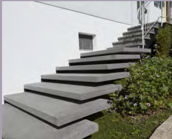
Freitragende Stufenelemente , wirken leicht und schwebend.
