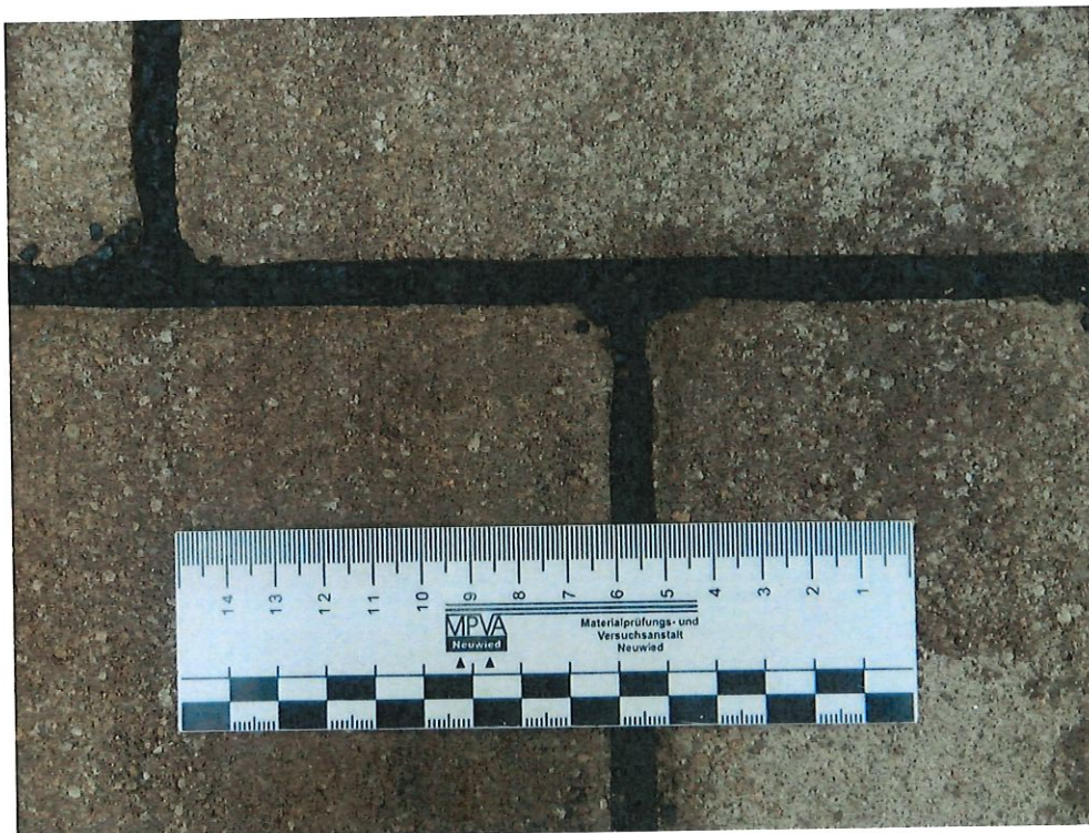
Bild 4: Resultierende Fugenbreite mit Fugenfüllung
