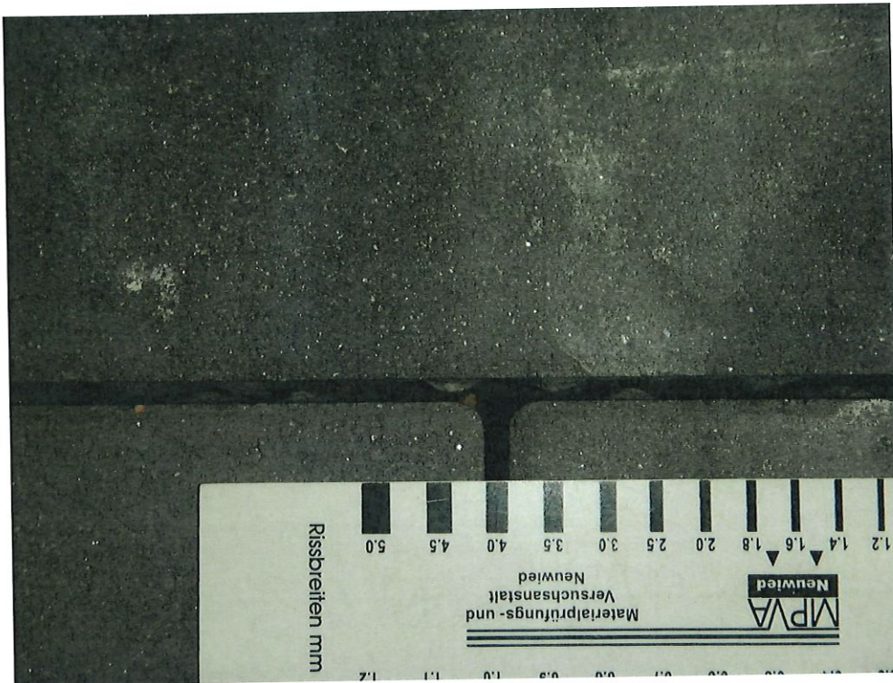
Bild 4: Resultierende Fugenbreite mit Fugenfüllung
